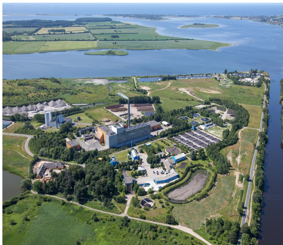
Rensningsanlægget ved Fjorden 18, 4700 Næstved
